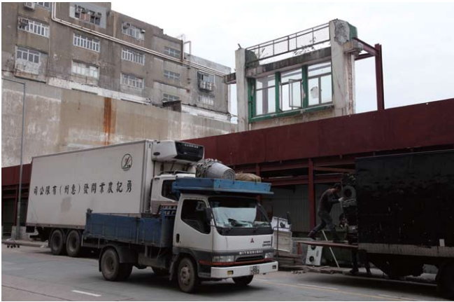
已評為三級歷史建築的東方紗廠只剩剩一幅外牆和玻璃窗
