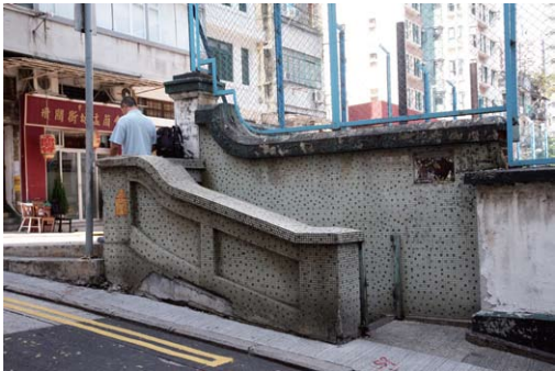
中環鴨巴甸街的地下公廁反映了昔日香港的生活環境
